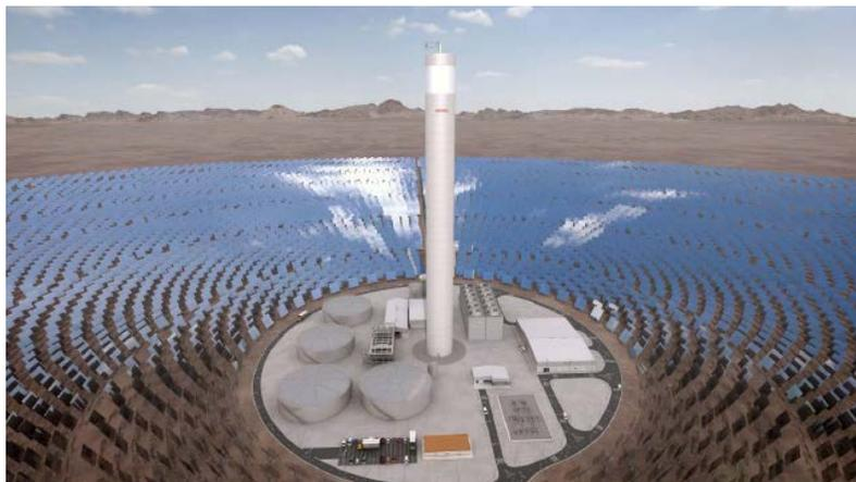
Planta de Concentración Solar de Abengoa, en el Desierto de Atacama con una torre de 250 metros y 10600 espejos heliostatos (Gentileza de Empresa Abengoa, España).
